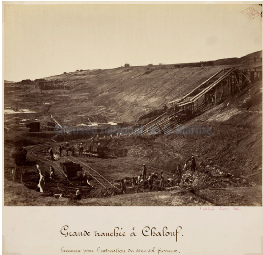
Figure 4. Ermé Désiré, French, “Grande tranchée à Chalouf. Travaux pour l'extraction du sous-sol pierreux,” 1867, Musée National de la Marine, Paris.
